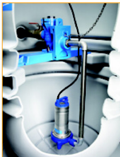
Postavitev potopne črpalke v fekalnem črpališču FLYGT Compit
